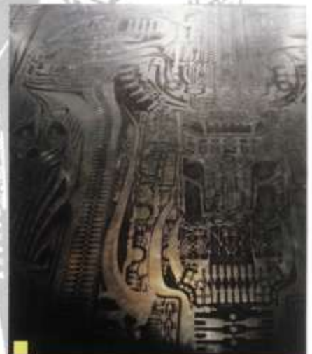
Relief-Bodenplatten aus Aluminium-Guss: Die Reliefausbildung (1.5mm) bringt Reinigungsprobleme, unterstützt aber die vom Künstler erwünschte Tiefenwirkung Kostenpunkt 120m 2 à SFr. 405,-
