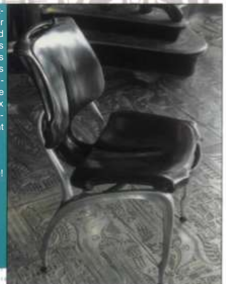
Relief-Bodenplatten aus Aluminium-Guss: Die Reliefausbildung (1.5mm) bringt Reinigungsprobleme, unterstützt aber die vom Künstler erwünschte Tiefenwirkung Kostenpunkt 120m 2 à SFr. 405,-
